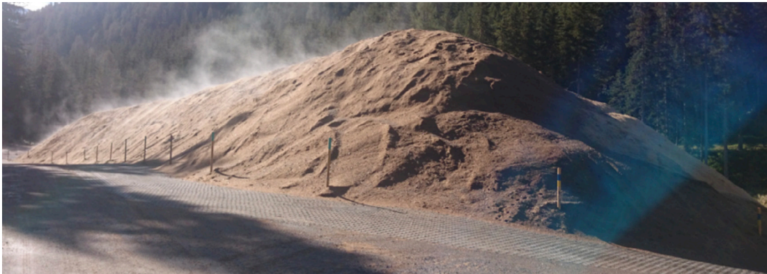
Abb. 13 Beispiel einer mit Holzschnitzeln überdeckten Snowfarming-Anlage (Quelle: Institut für Schnee- und Lawinenforschung, SLF)
