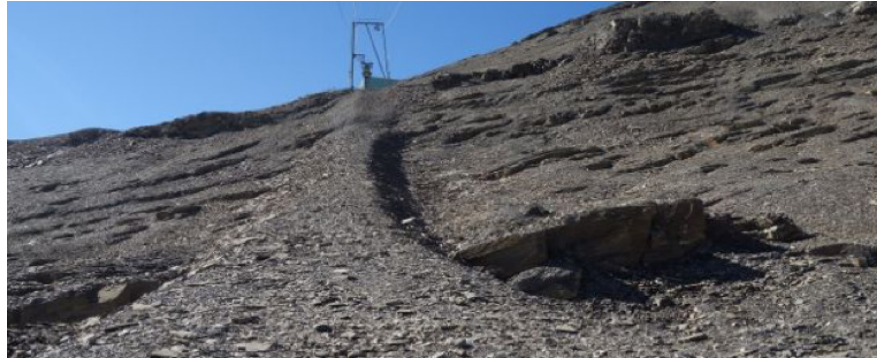
Abb. 2 Ursprüngliche Skiliftanlage (Blick Richtung Bergstation Plaine Morte); die Masten wurden rückgebaut, der Damm ausgebaut (Foto: ecoptima AG, Aug. 2015)
