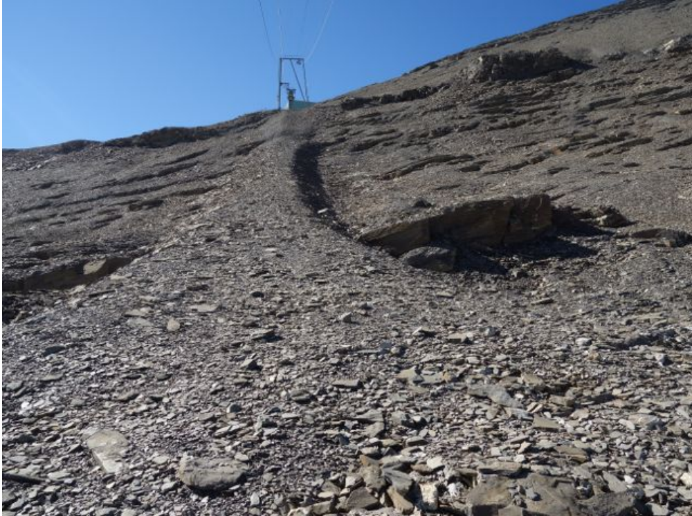
Abbildung 7f. Der aufgeschüttete Damm (Skilifttrasse) wird rückgebaut. Ein Teil des Materials wird verwendet, um zwei Senken im Längsgefälle der Skipiste auszugleichen. Das Gelände ist vegetationsfrei.
