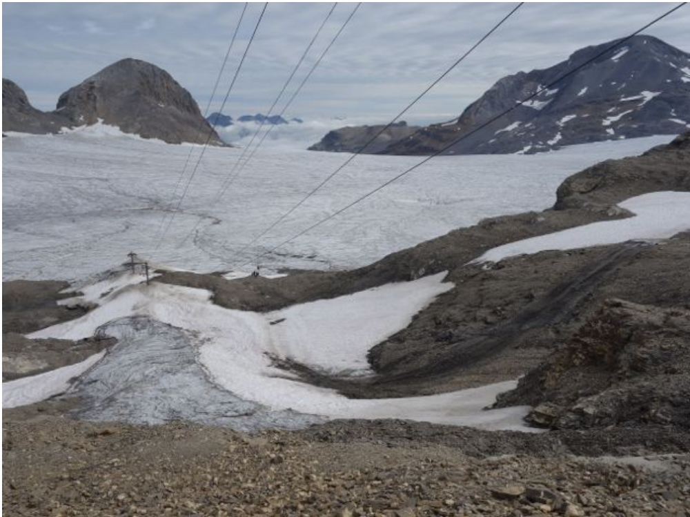
Abbildung 7b. Blick vom Skiliffttrassee aus zur Talstation des Skilifts.
