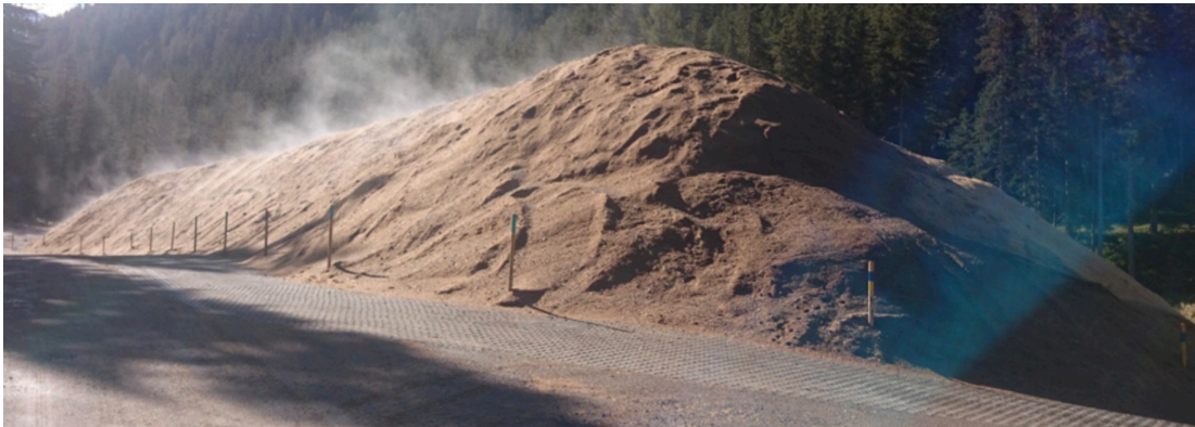
Abb. 13 Beispiel einer mit Hackschnitzeln überdeckten Snowfarming-Anlage (Quelle: Institut für Schnee- und Lawinenforschung, SLF)
